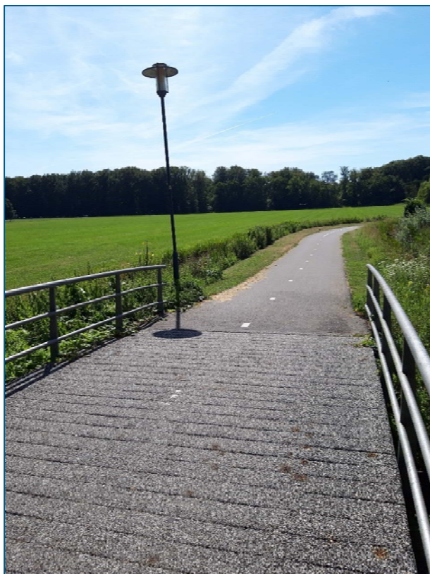
Figuur 2-7. Fietsbrug vanaf de Leeuwenlaan (Foto: RHDHV 2020).
