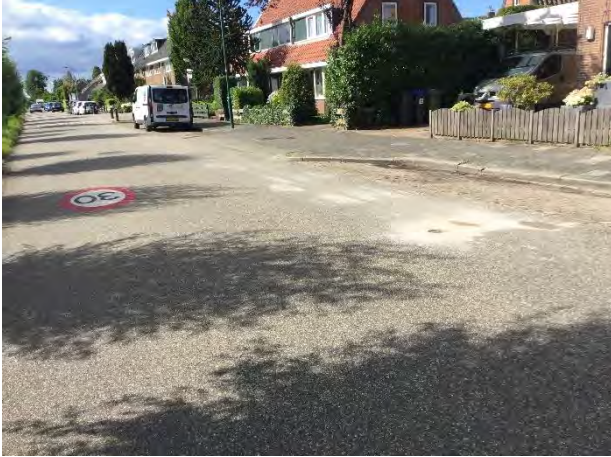
Bijlage foto 4 asfaltboring 3
