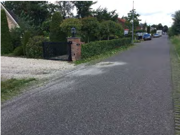
Bijlage foto 5 asfaltboring 4
