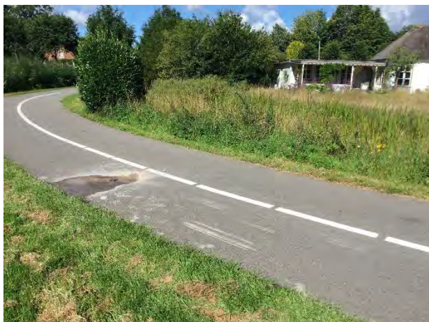
Bijlage foto 2 asfaltboring 2
