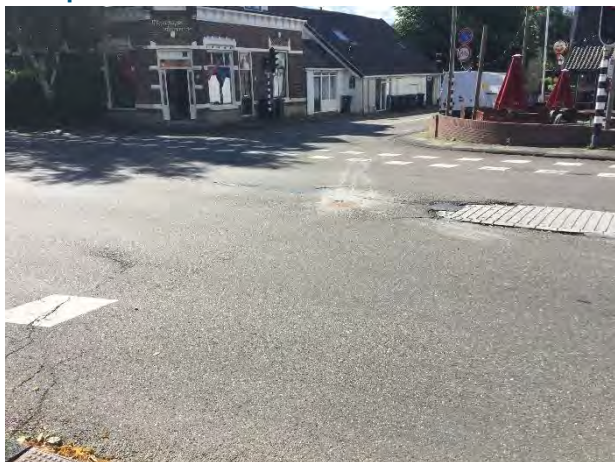
Bijlage foto 1 asfaltboring 1
