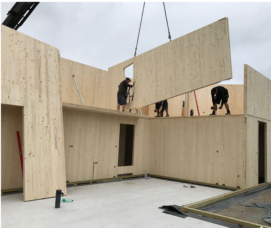
cross laminated timber (CLT) buitenwanden waarbij er gelet wordt op losmaakbaarheid
