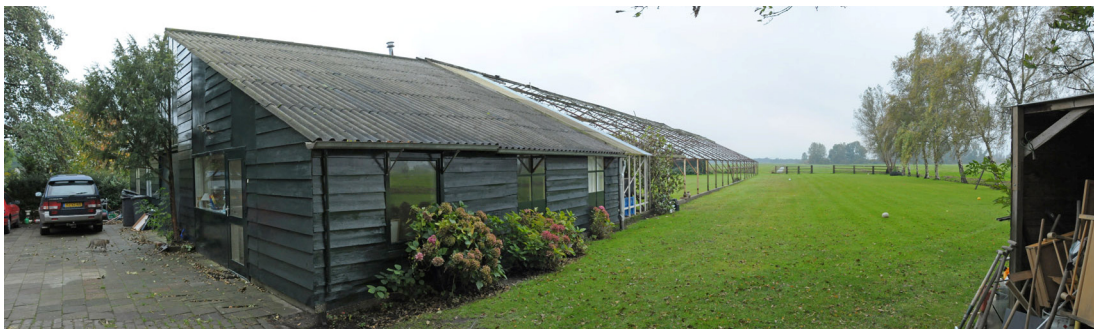
figuur 11 – de te vervangen opstal
