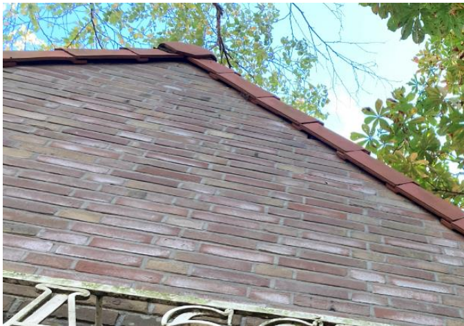
Figuur 8 Openingen bij de kopgevel van object 1
