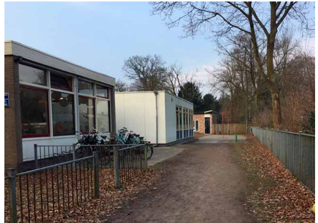
6. zicht langs de uitbouw
