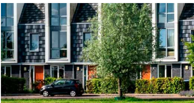
lage dakgoot met overstek, begane grond niet in materiaal kap
