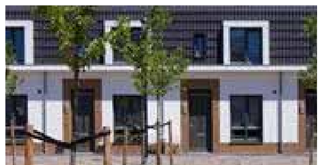
lage dakgoot met overstek
