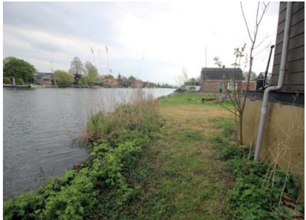
Bestaande situatie, deels een zachte oever en deels een harde beschoeiing
