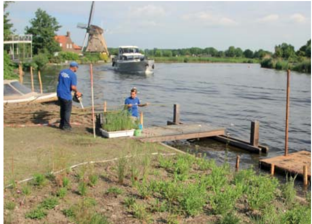
Aanleg voorbeschoeiing van wilgentenen en aanplant nieuwe rietoever (project Eilandseweg 67a Nigtevecht)
