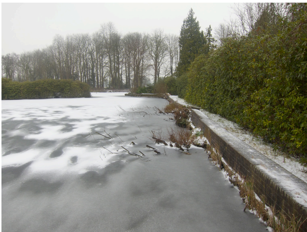
Figuur 2.2 Deel van de 120 m lange kademuur in het oostelijke deel van het landgoed, met rododendronstruwelen.
