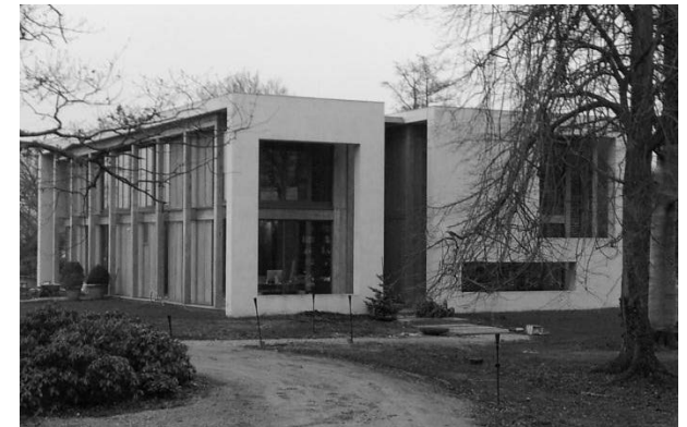
Oud Over 160 (2011) is gebouwd in een moderne kubistische stijl en vormt een groot contrast met de andere bebouwing op het landgoed.
