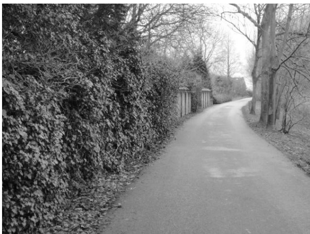
2. Zicht vanaf de entree aan Oud Over in zuidwestelijke richting. Het landgoed heeft een besloten karakter aan de Vecht door de oude tuinmuur en omhaging.
