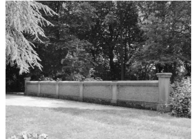
Afb. 29 De gemetselde brug over sloot
