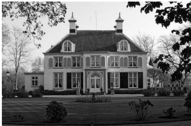
Buitenplaats Nieuwerhoek, Rijksweg 78. Begin 18 e eeuwse rechthoekig herenhuys van 5 traveeën breed met omlappend schilddak met vierkante schoorstenen.
