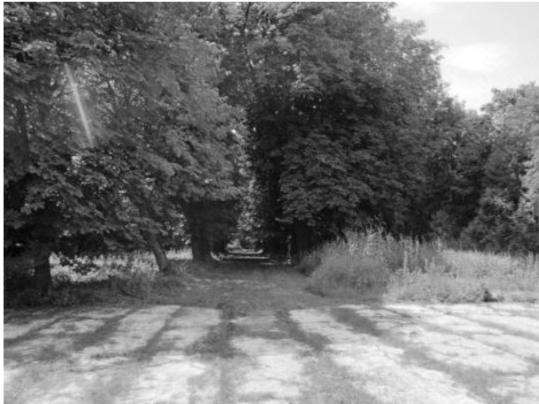
Afb. 25 De betonnen funderingsplaat van het nooit gerealiseerde hoofdhuis .
