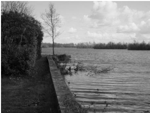
Afb. 26 De vermoedelijke locatie van het voormalige schuithuis wordt bevestigd door de kademuur met aanlegingen voor boten.
