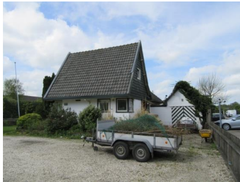
Woning met garage
