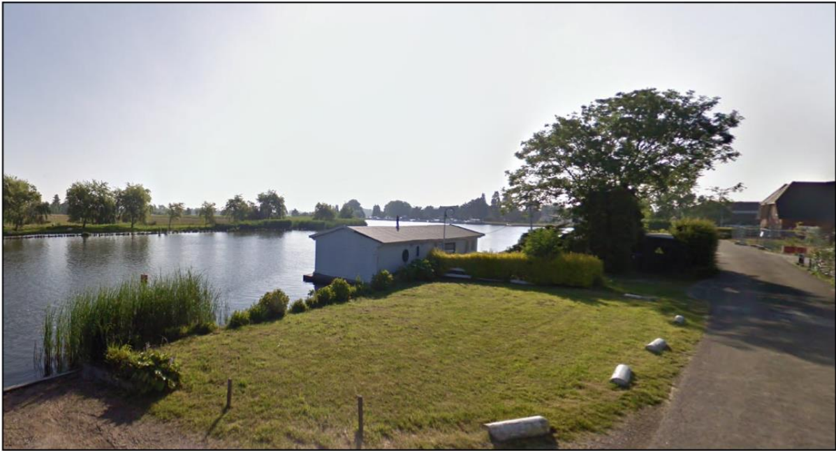
Afbeelding 2.2: Straatbeeld van het plangebied vanaf de Eilandseweg (Bron: Google Streetview, 2009)
