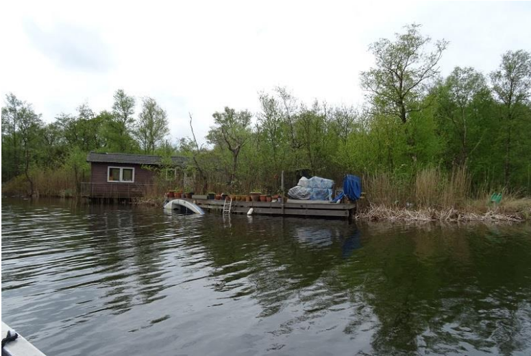
Oude vervallen opstallen die verwijderd worden
