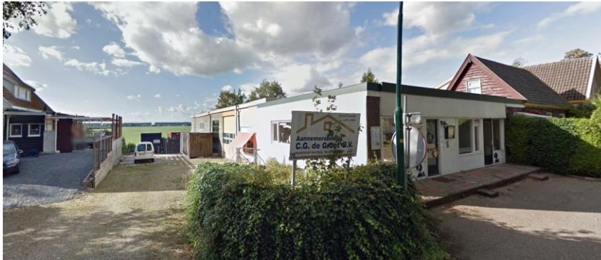
Afbeelding 3: Bestaande situatie (nummer 2 links en nummers 3 en 4 aan de rechterzijde).
