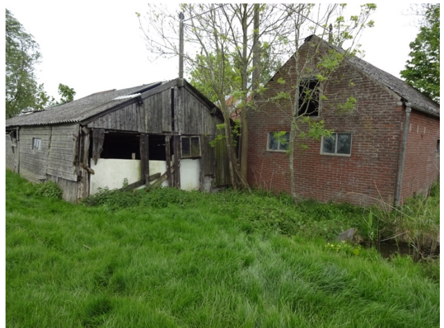
bouwvallige opstallen als verblijfplaats vleermuizen?
