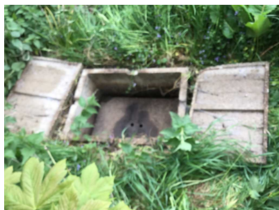
vlakke plaat (watermeterput)
