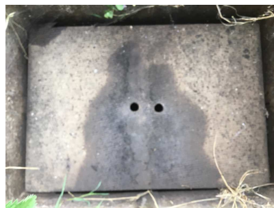
vlakke plaat (watermeterput)
